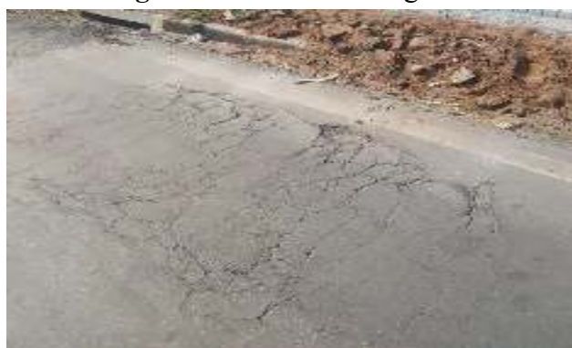
Figura 4 - Trincas interligadas.
