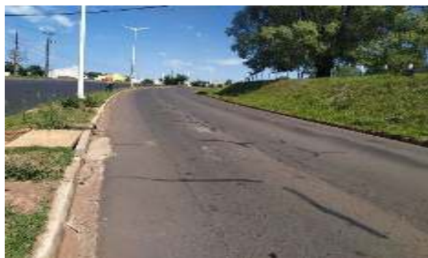
Figura 6 - Fissuras.
