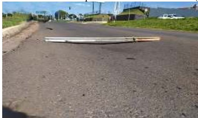
Figura 7 – Afundamento plástico nas trilhas de roda (ATP).
