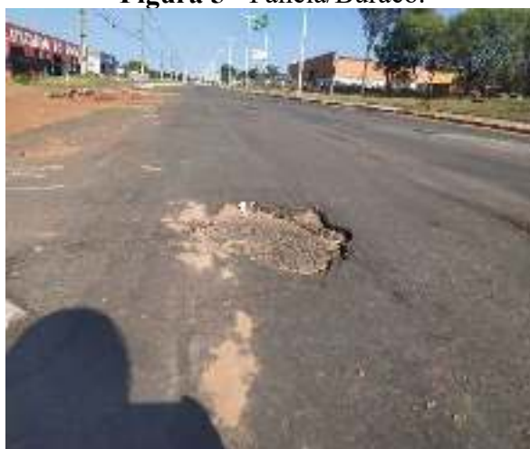
Figura 5 - Panela/Buraco.
