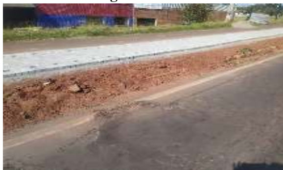
Figura 3 - Remendo.
