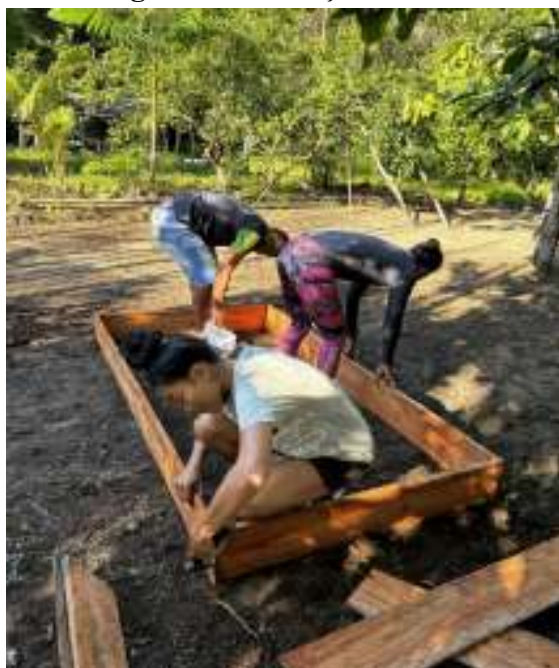
Figura 2-construção dos Canteiros
