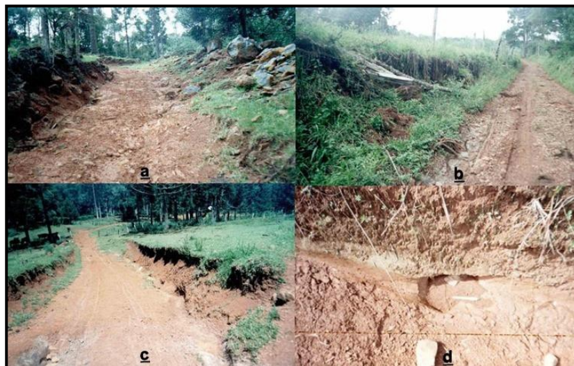
Figura 3: Processos erosivos em estradas da bacia do rio do Atalho, PR: a) Estrada junto ao relevo montanhoso e aflorado de rochas; b) Estrada mensurada com a queda do talude e cerca dos animais; c) Estrada em área de pastagem com sulcos de erosão; d) Formação de marmitta na base do talude do barranco.
