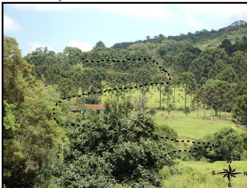
Figura 2: Estrada construída junto à vertente na Bacia do Rio do Atalho, PR
