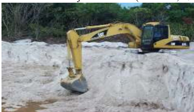
Escavadeira cavando jazida de areia (ARAUJO, 2020)
