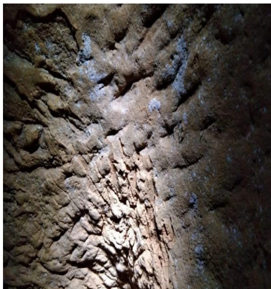
Fig.3- Fotografia de marcas na parede interna da estrutura, sendo possível observar sulcos longitudinais e arranhões.
