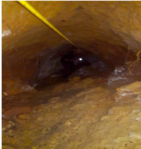
Fig.2- Fotografia do primeiro segmento desobstruído.
