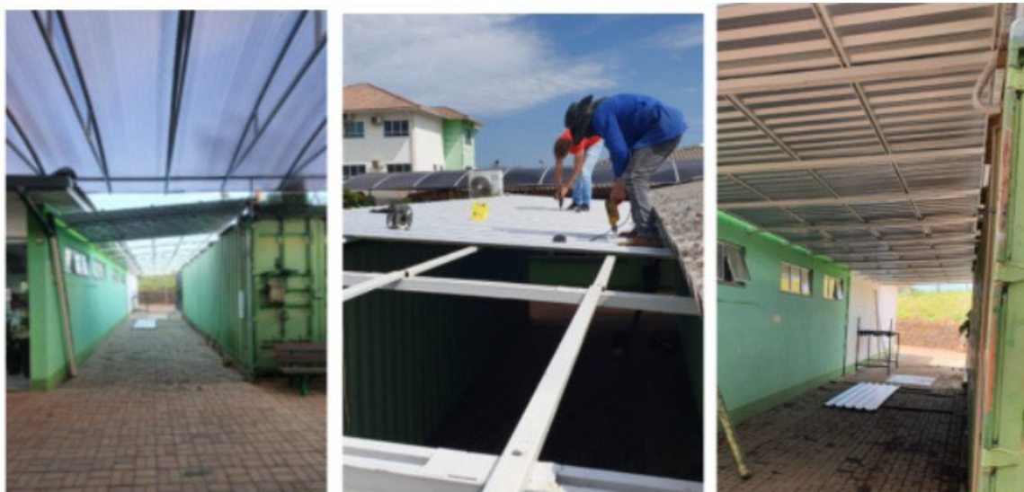
Figura 8 - Montagem da estrutura no local planejado
