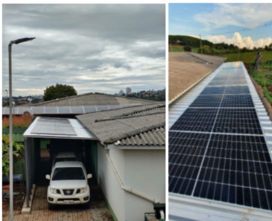
Figura 9 - Instalação das placas fotovoltaicas
