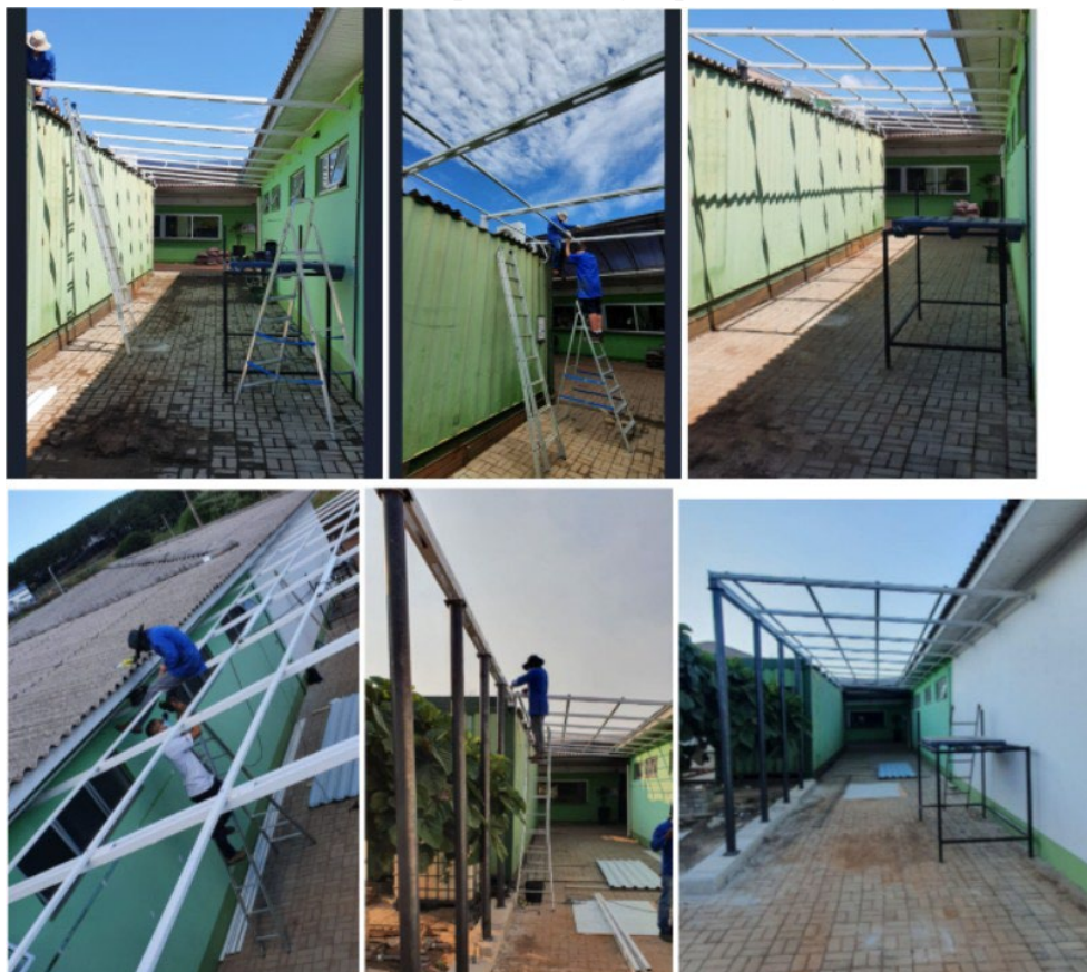
Figura 7 - Montagem da estrutura no local planejado
