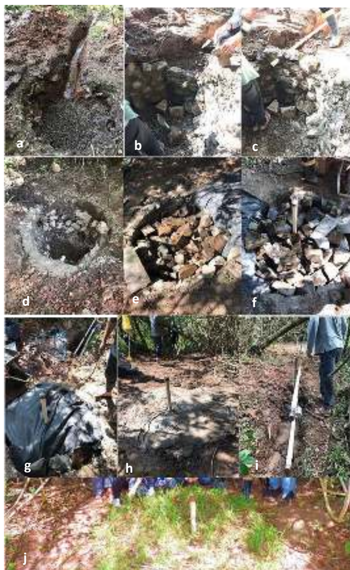
Figura 3 – ilustração das etapas da implementação do sistema caxambú. (a) revestimento do fundo com brita e drenagem da água acumulada; (b, c) montagem da represa com os canos de drenagem, captação e de transbordo; (d) revestimento da borda da nascente com massa solo\cimento; (e) preenchimento da nascente com pedras; (f) instalação do cano de sanitização. (g) cobertura da nascente com manta geotêxtil (h) vedação da nascente com massa solo\cimento; (i) proteção da saída dos canos com malha de nylon e (j) cobertura da nascente com solo e gramínea local. Fonte: Autores (2022)
