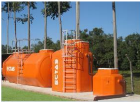
Figura 2: Estação de Tratamento de Esgoto Compacta
