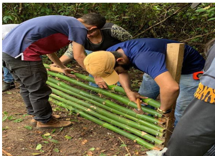
Imagem 2 – bambus sendo pregados nas pernamancas.
