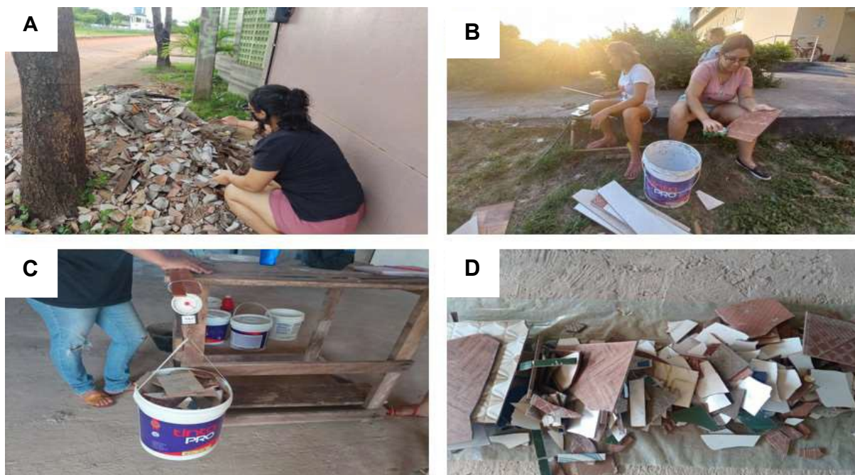
Figura 1: Etapas iniciais do projeto. A – Resíduos cerâmicos sendo coletados nas ruas. B – Lavagem dos resíduos cerâmicos coletados. C – Pesagem dos resíduos cerâmicos. D – Resíduos cerâmicos separados. Fonte: Acervo digital “Projeto ARTEduca”
